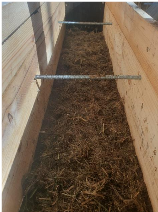
Slika 0.5 Vlakna industrijske konoplje dodavana između slojeva nabijene zemlje
