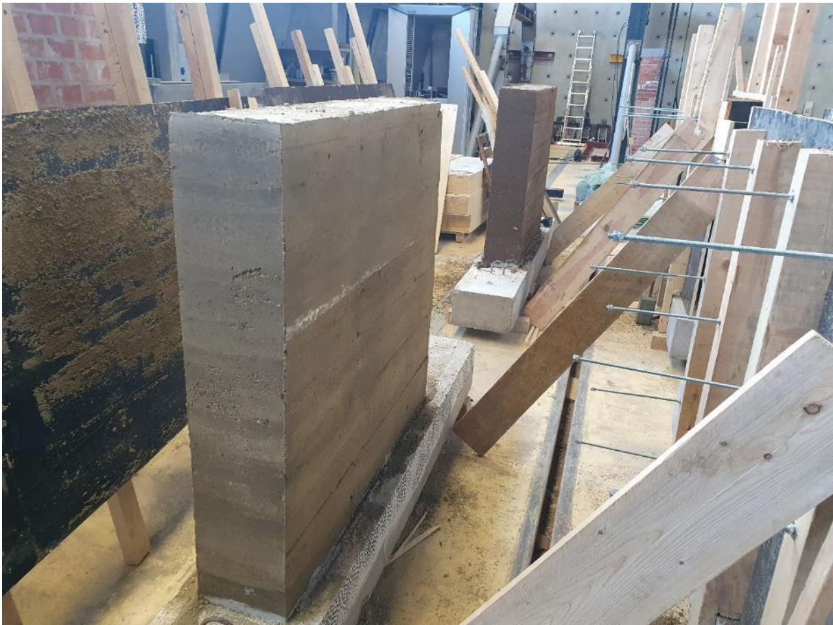
Slika 0.6 Trenutak nakon uklanjanja drvene oplata
