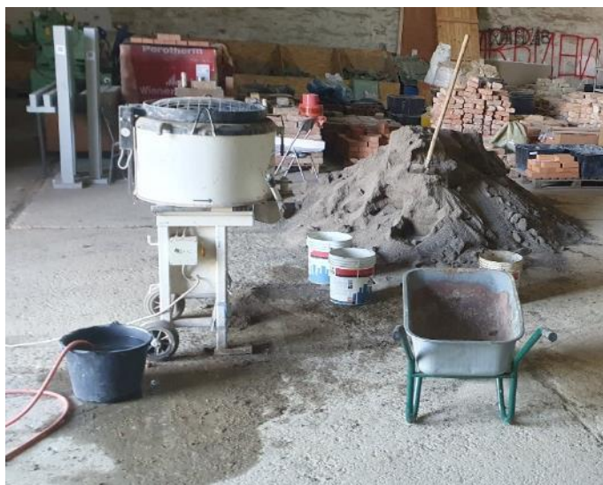
Slika 0.1 Priprema materijala za izradu zidova
