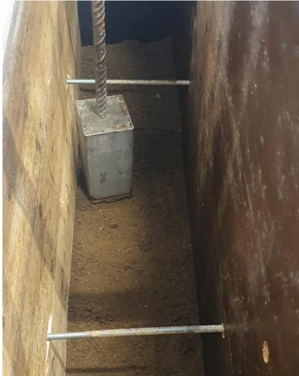
Slika 0.4 Metalni nabijač korišten prilikom izrade zemljanih zidova
