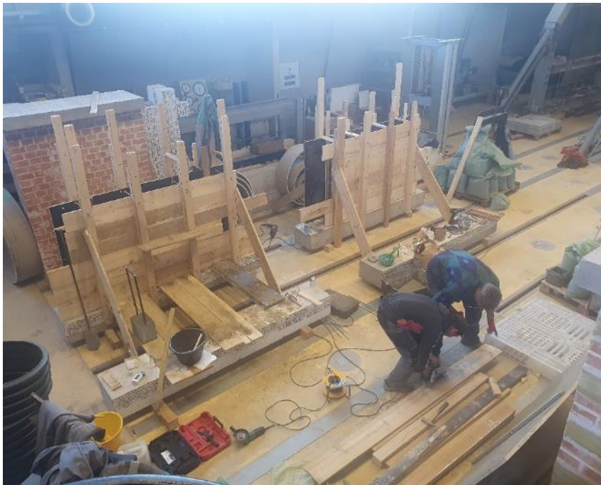
Slika 0.3 Priprema drvene oplata za izgradnju zidova od nabijene zemlje
