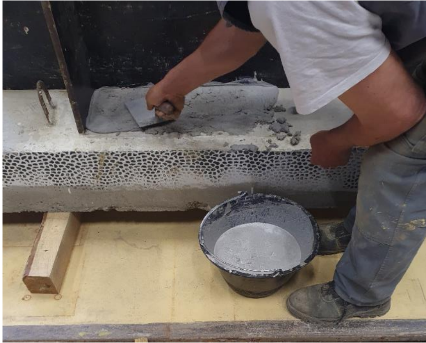
Slika 0.2 Postavljanje vapnenog morta na betonskoj gredi
