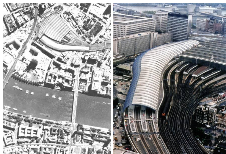
LONDON, Waterloo internacionalni željeznički Terminal 1990-1993. arh: N. Grimshaw & Part.
