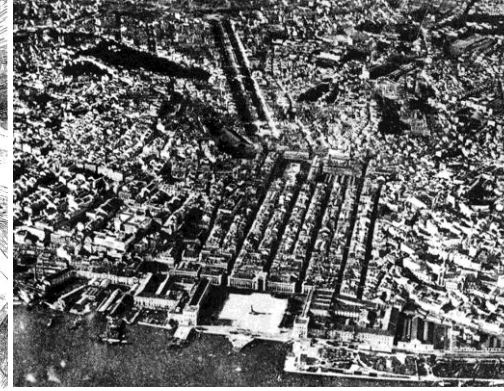
Lisabon, Portugal blokovski organiziran dio grada izgrađen je nakon potresa 1756. g. na nestabilnom pjeskovitom tlu. Lateralne, nepravilne strukture su dio očuvanih dijelova grada izgrađenih na stijenvitu tlu, koji u potresu nisu doživjeli razaranja.
