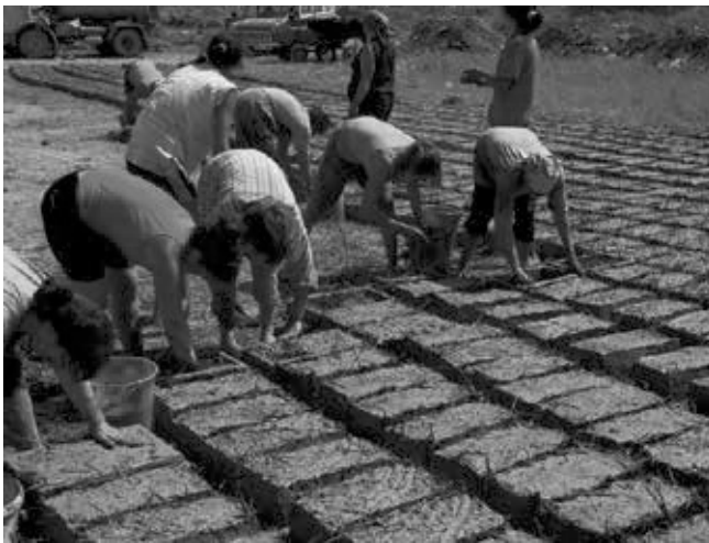
Herstellung von Lehmziegeln in Rumänien
