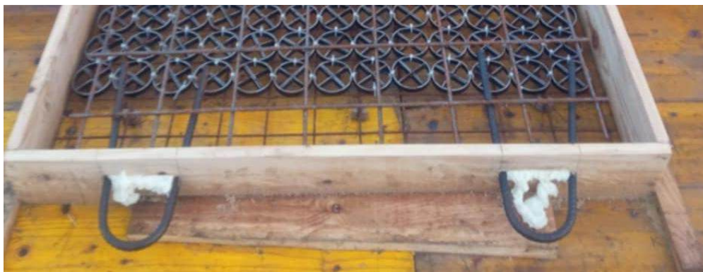
Slika 4.7: Osiguranje zaštitnog sloja i veze između gornje i donje armature na prednjoj i stražnjoj strani
