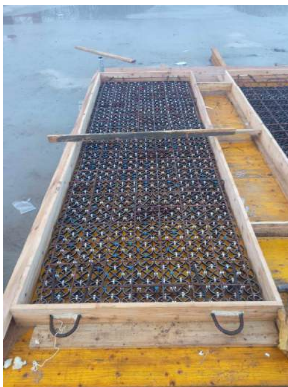
Slika 4.1: Raspored pojačanja plošnog nosača prije betoniranja
