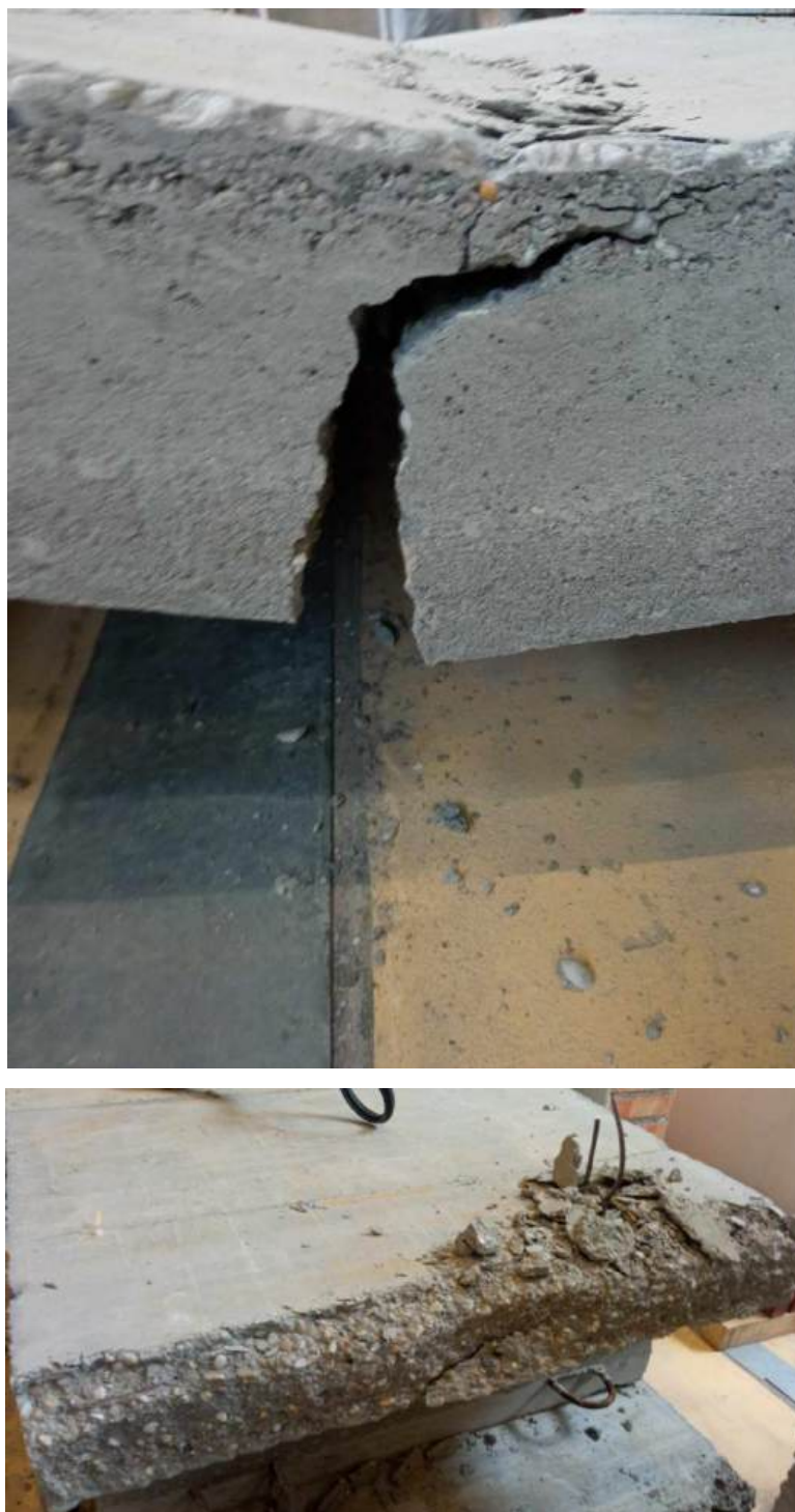
Slika 4.53: Oštećenje plošnog nosača P-K-3 tijekom opterećenja
