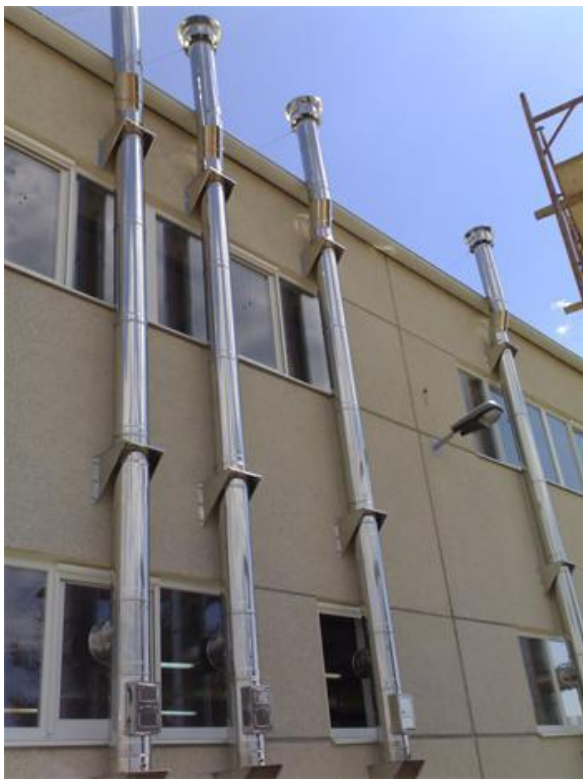
Prislonjeni dimnjak pekarnice
