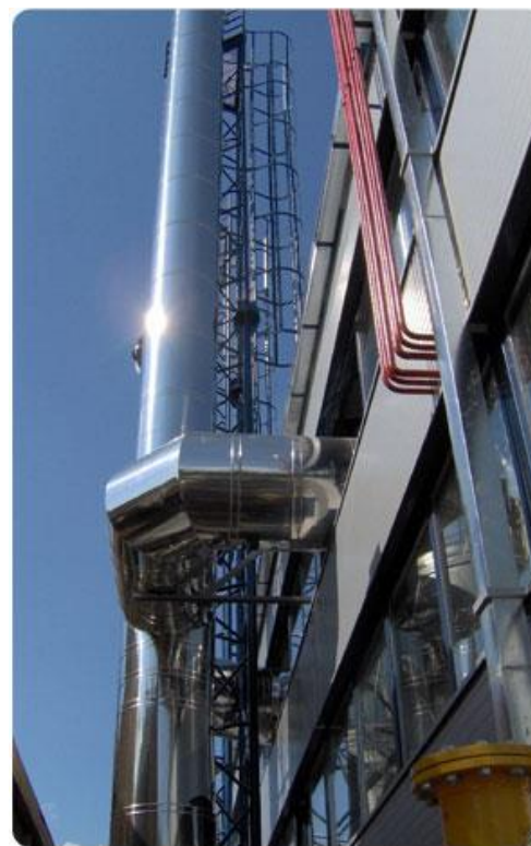
Industrijski samostojeći dimnjak
