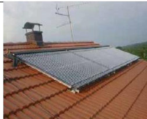
vakumski kolektori u okomitoj izvedbi
