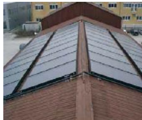
pločasti kolektori u okomitoj izvedbi
