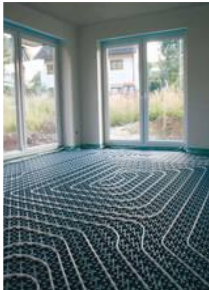
Primjer postavljanja cijevnog razvoda podnog grijanja
