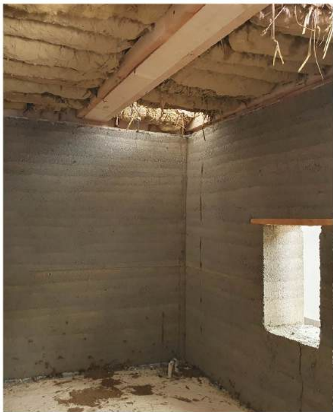
Model zemljane kuće s tradicijskom stropnom konstrukcijom
