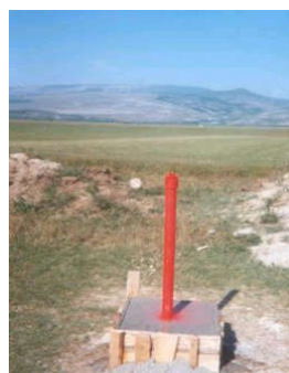
konačan izgled piezometra
