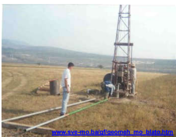
ugradnja piezometra
