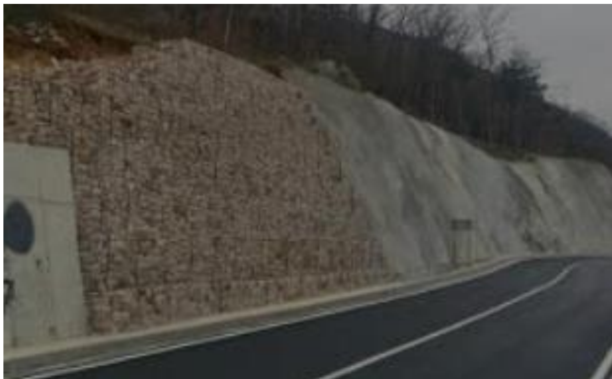
Slika: Gabionski zid
