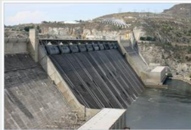
Brana Grand Coulee je primjer gravitacijske brane
