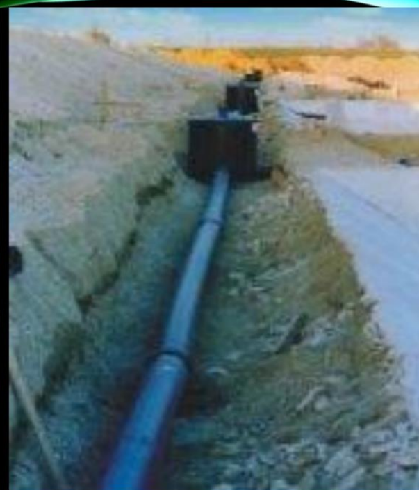
Ugradnja drenažnih cijevi
