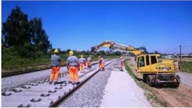
Izgradnja nove pruge za prigradski promet na dionici Gradec-Sveti Ivan Žabno | HŽ Infra... hznfra.hr
