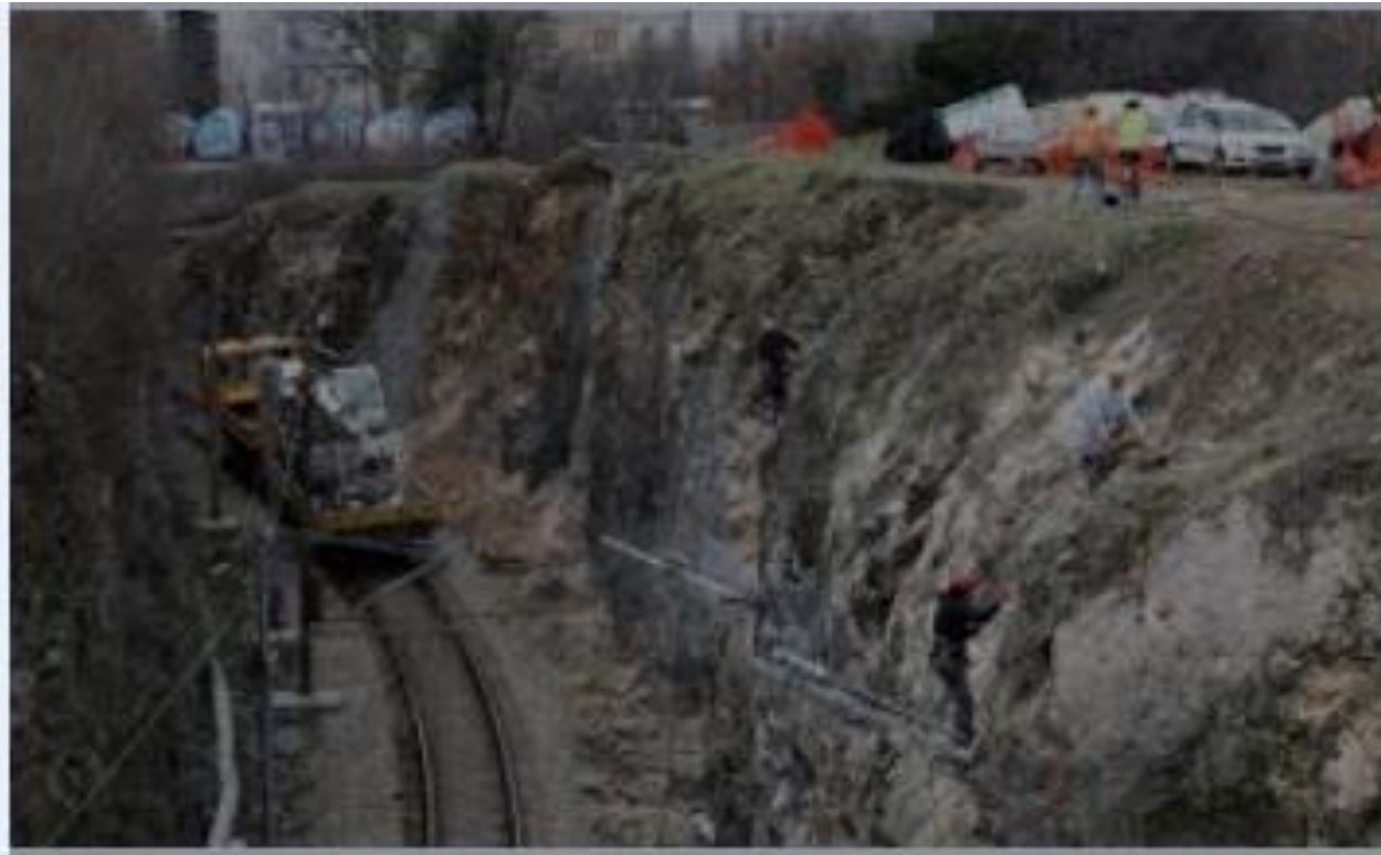
Pruga Zagreb – Rijeka (kanjon na Gornjoj Vežici)
